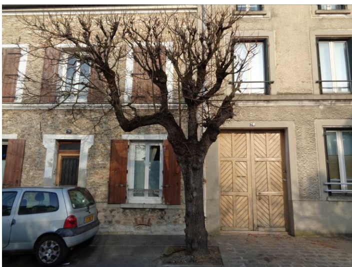
Avenue de Paris, tilleul n° 88 : houppier déséquilibré suite à la réduction d'une charpentière devant un portail
