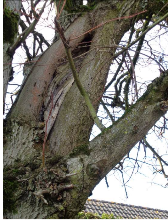
Avenue de la République Tilleul n°125 : plaie d'arrachement sur charpentière
